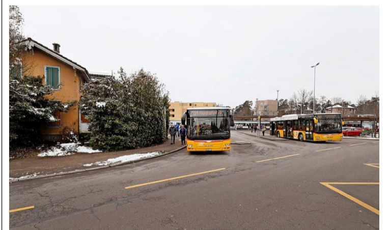
Der neue Bushof wird am bisherigen Standort gebaut. Foto: Balz Murer
